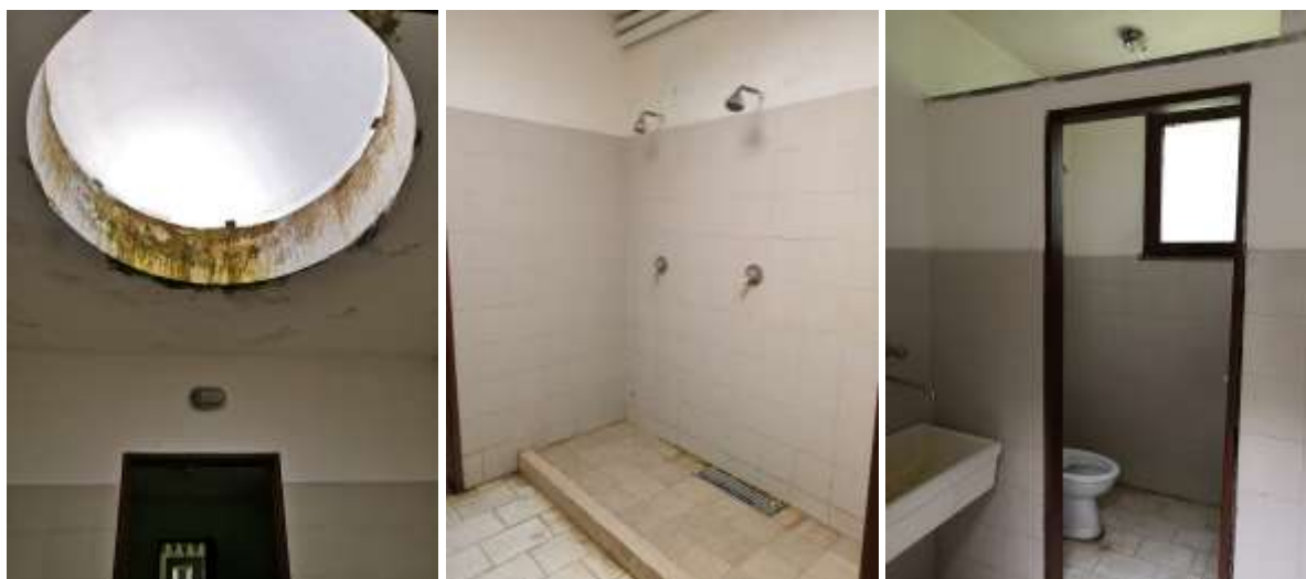
Figura 6: immagini esplicative delle condizioni attuali dei locali interni
